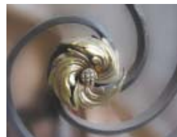
Detal metalowej balustrady
