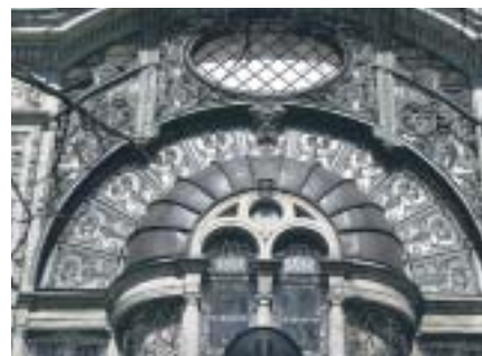
Detale z południowej elewacji
