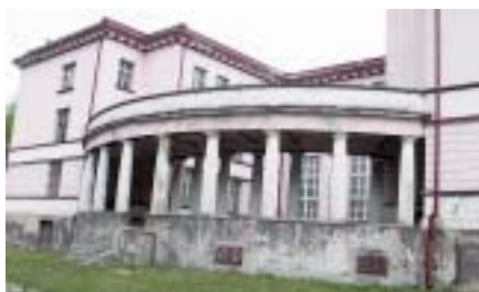
Budynek od strony południowej
