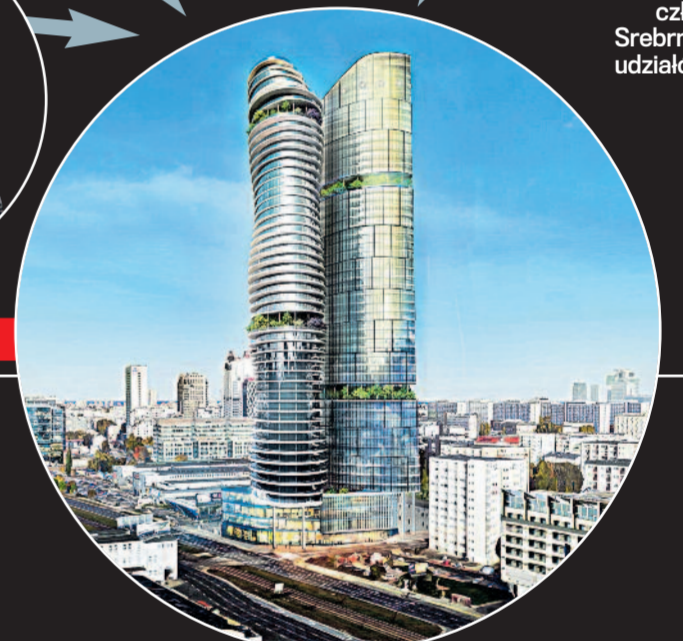
SREBRNA projekt K-Towers, Warszawa, ul. Srebrna 16, planowana siedziba Instytutu im. Lecha Kaczyńskiego
